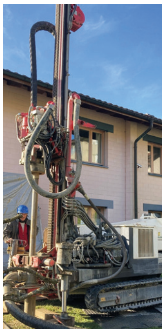
Erdsondenbohrungen mit dem kleinsten Bohrergerät der Schweiz.
