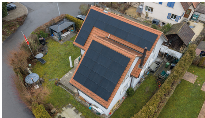
AEW: Jetzt clever heizen, Strom produzieren und Steuern sparen.
