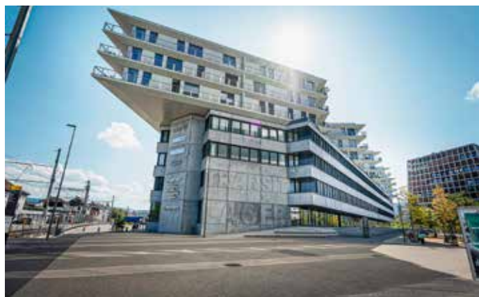
Firmensitz von smeyers im Transitlager Dreispitzareal in Münchenstein
