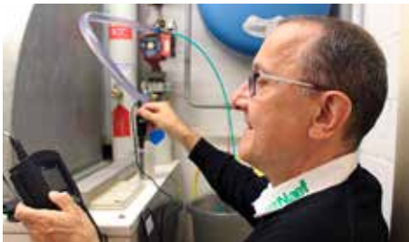
Umfassende Zustandsanalyse vor Ort.
