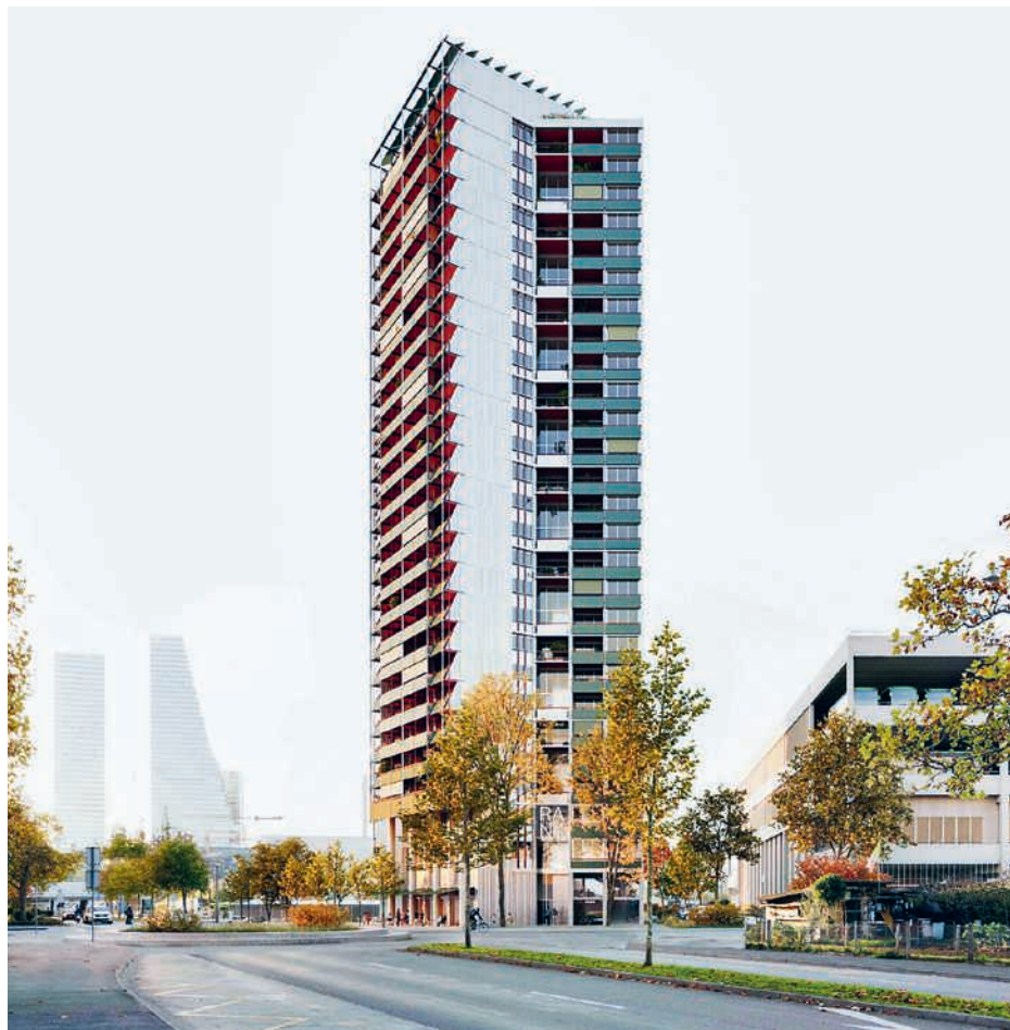
Wohnhochhaus – Blick von der Grenzacherstrasse nach Westen.
