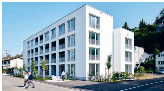
Mehrfamilienhaus, Minergie-A, Aarau.
