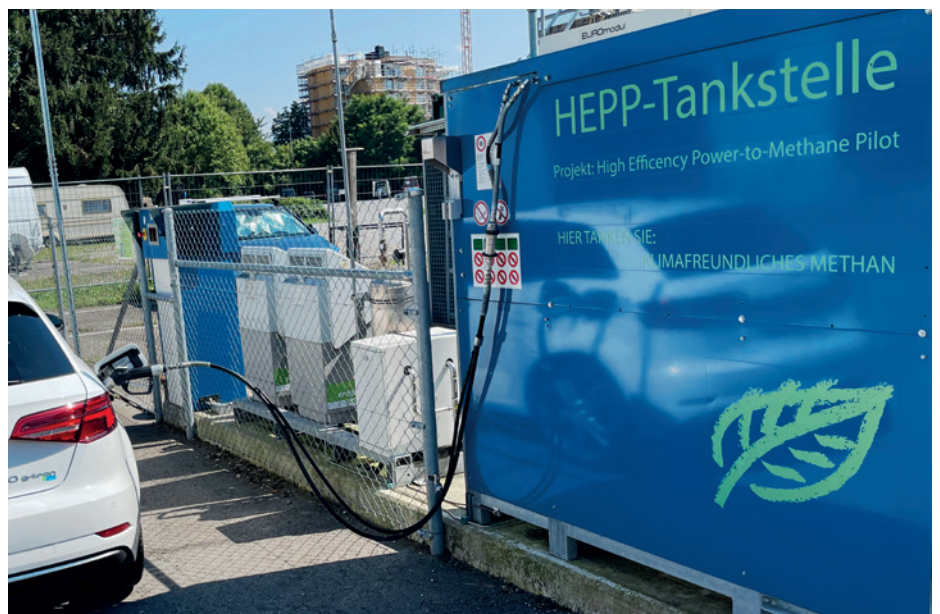
Das Methangas kann an der hauseigenen Tankstelle zur Betankung von Fahrzeugen genutzt werden.
