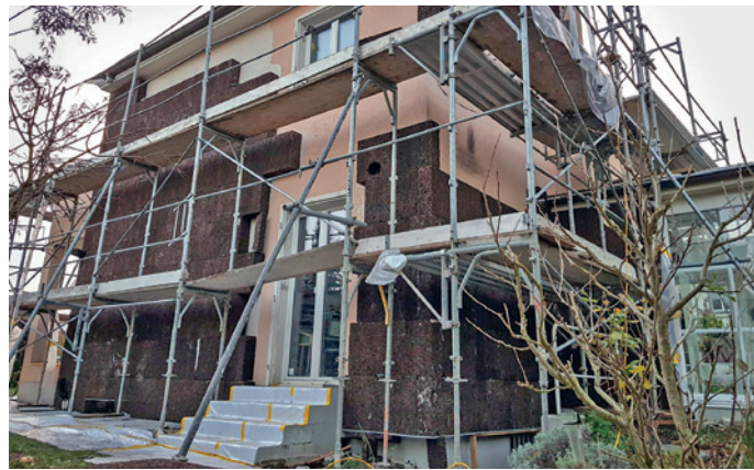
Sanierung mit Bio-Korit® Korkdämmplatten im WDVS.
