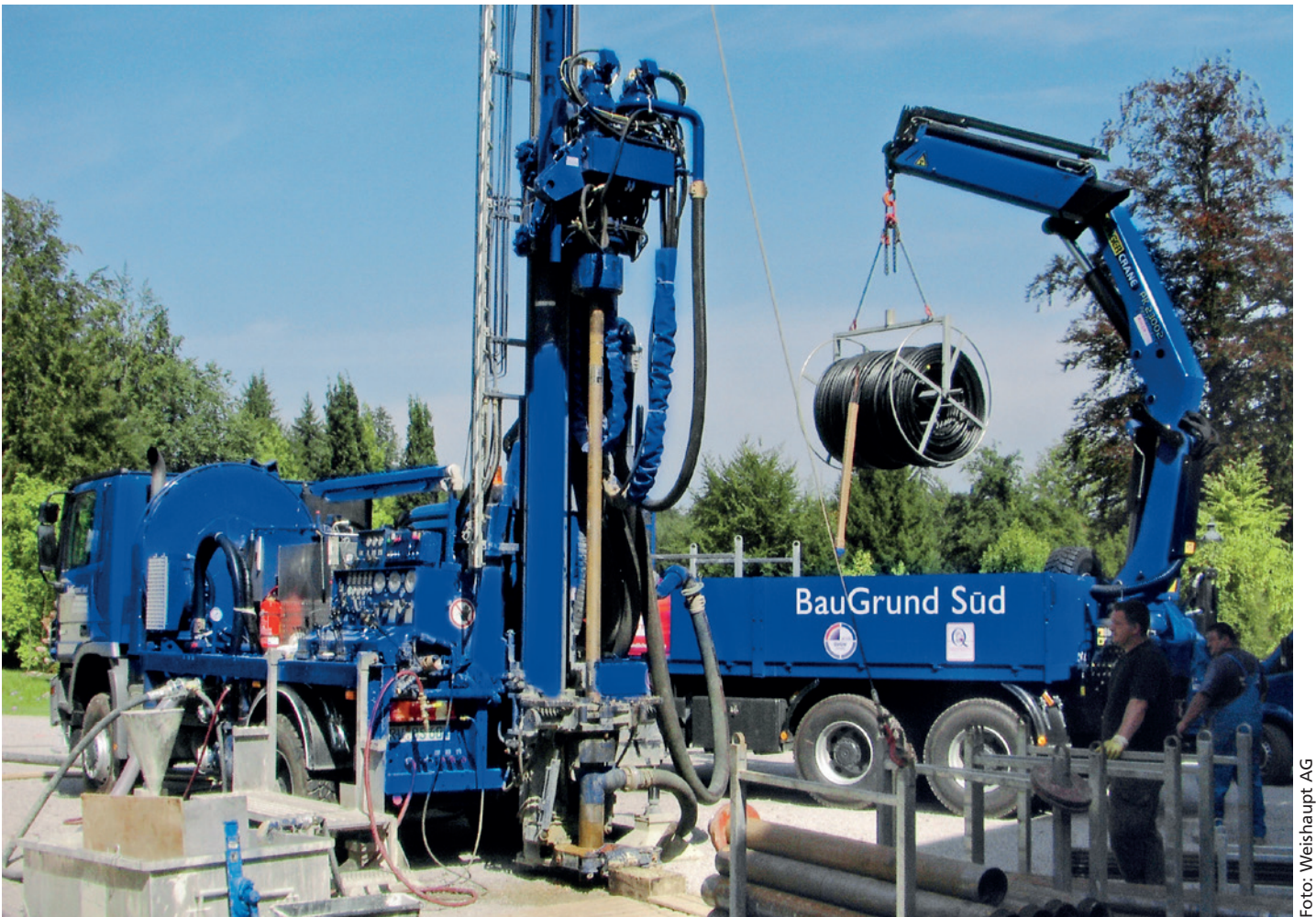
Tiefenbohrung für eine Erdwärmesonde.
