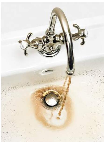
Rostwasser im Lavabo deutet auf die Alterung der Trinkwasserinstallation hin.
