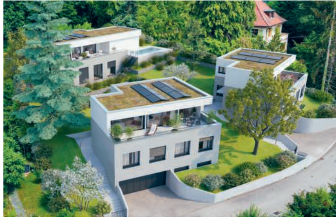
Neubau 3 freistehende EFH in Arlesheim
