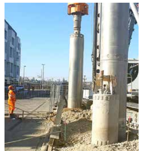
Einbringen der Bohrpfähle mit der Bohrmaschine am 14. Februar 2023 an der Meret-Oppenheim-Strasse.
