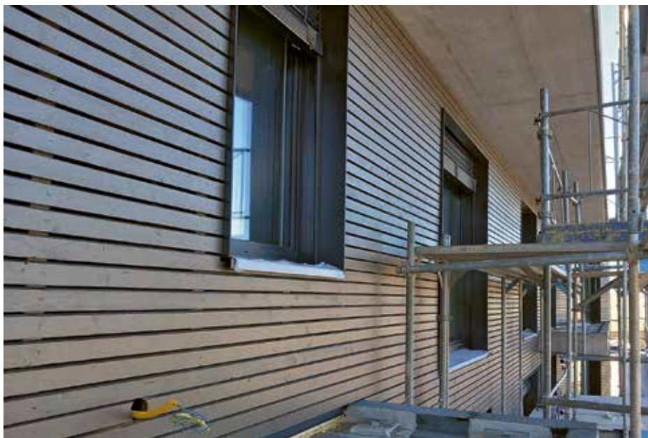
Ansicht einer verkleideten Fassade.
