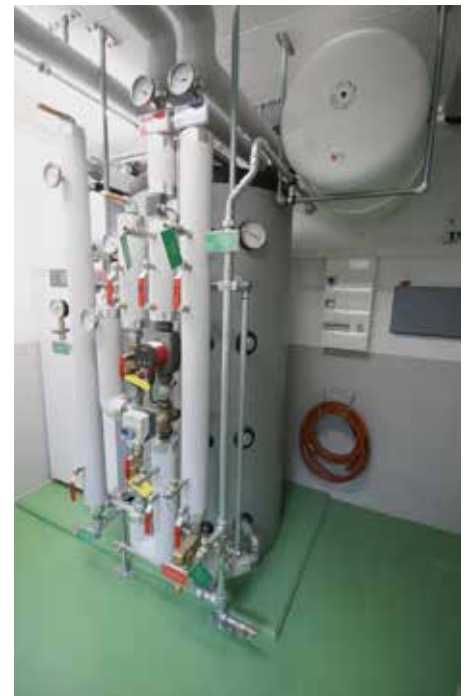
Inneneinrichtung der rechteckigen Wärmepumpe.
