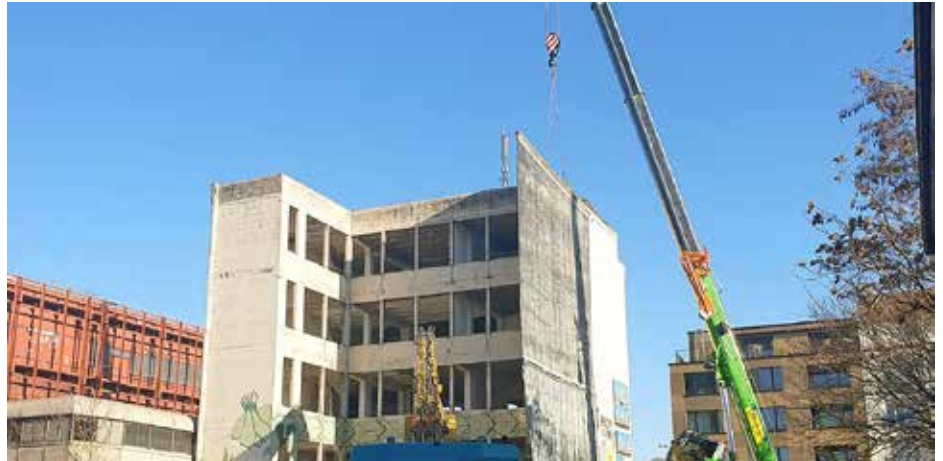
Der Abbruch des gleisnahen Gebäudes an der Solothurnerstrasse 4 am 14. Februar 2023.
