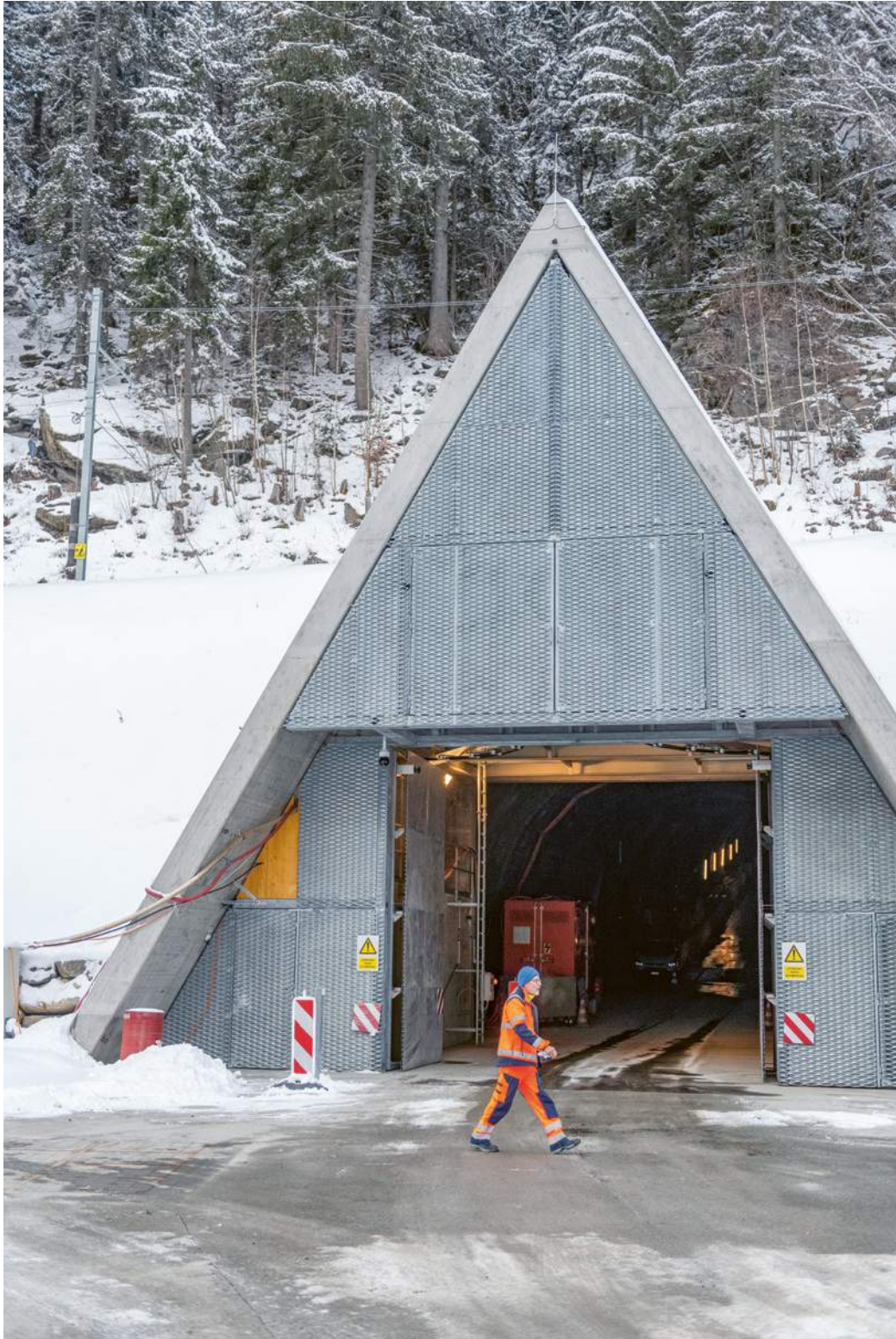
Unscheinbarer Eingang in die Unterwelt: Abgesehen von der Staumauer sind die meisten Anlagen im Pumpspeicherkraftwerk unterirdisch. Kilometerlange Stollen verbinden sie miteinander.
