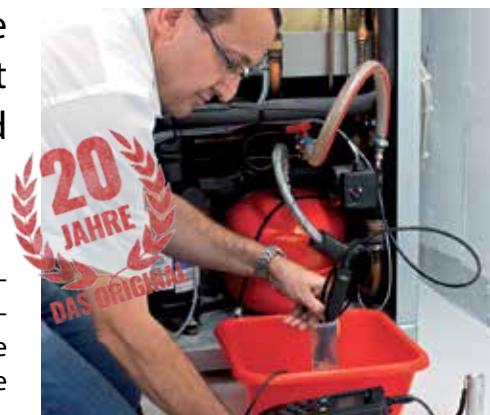
Das HAT-System ist seit 1999 im Einsatz.
