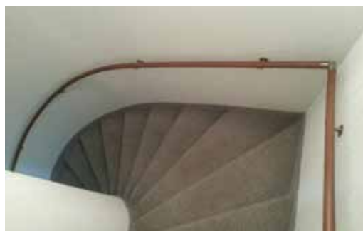
Ein Innenhandlauf, wandseitig aussen.
