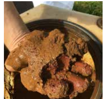
Entfernte Ablagerungen werden fachgerecht entsorgt. Nach dem fachmännischen Reinigen haben es die Bewohner – auch in den Wintermonaten – innerhalb eines Tages wieder wohligh warm.
