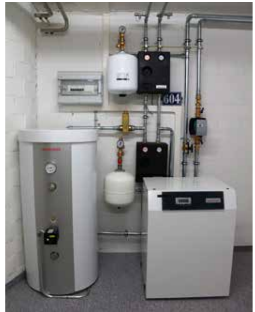
Weishaupt Sole/Wasser-Wärmepumpe WWP S 8 ID (Sole/Wasser) mit einer Wärmeleistung von 8,1 kW und einem 200-l-Energiespeicher WES 200 Eco/WP.
