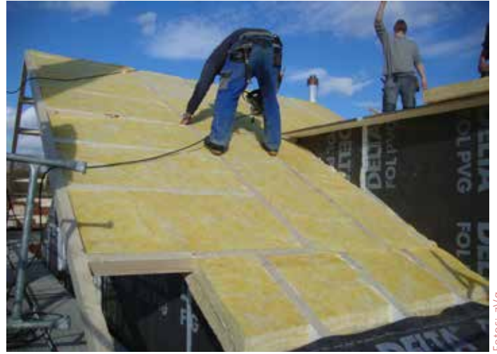
Ein Dach wird in der Regel innen sowie unter, zwischen und über den Sparren isoliert.
