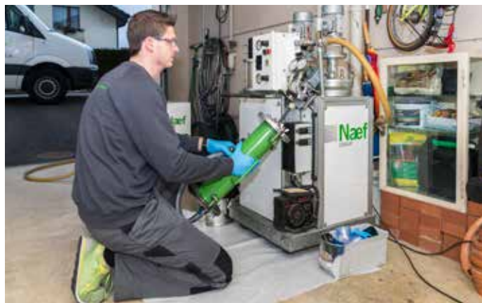
Mit dem HAT-System geht es sanierungsbedürftigen Bodenheizungen an den Kragen.
