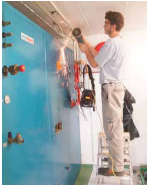
Die alte Elektropeicherheizung muss raus.
