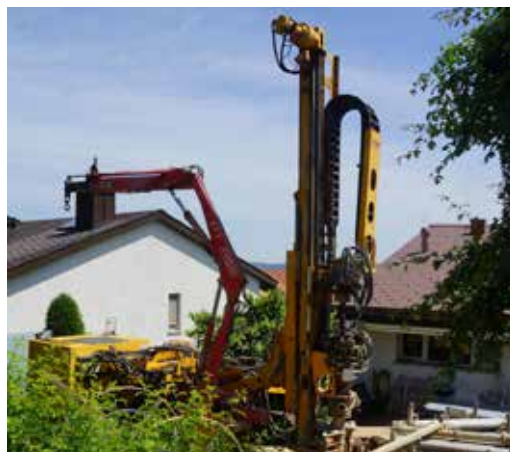
Pro Haus wird eine Erdsonden-Bohrung realisiert.
