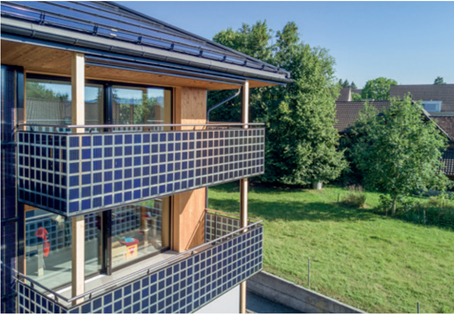
Dach und Fassade des MFH in Fahrwangen produzieren jährlich 78'000 kWh Solarstrom.
