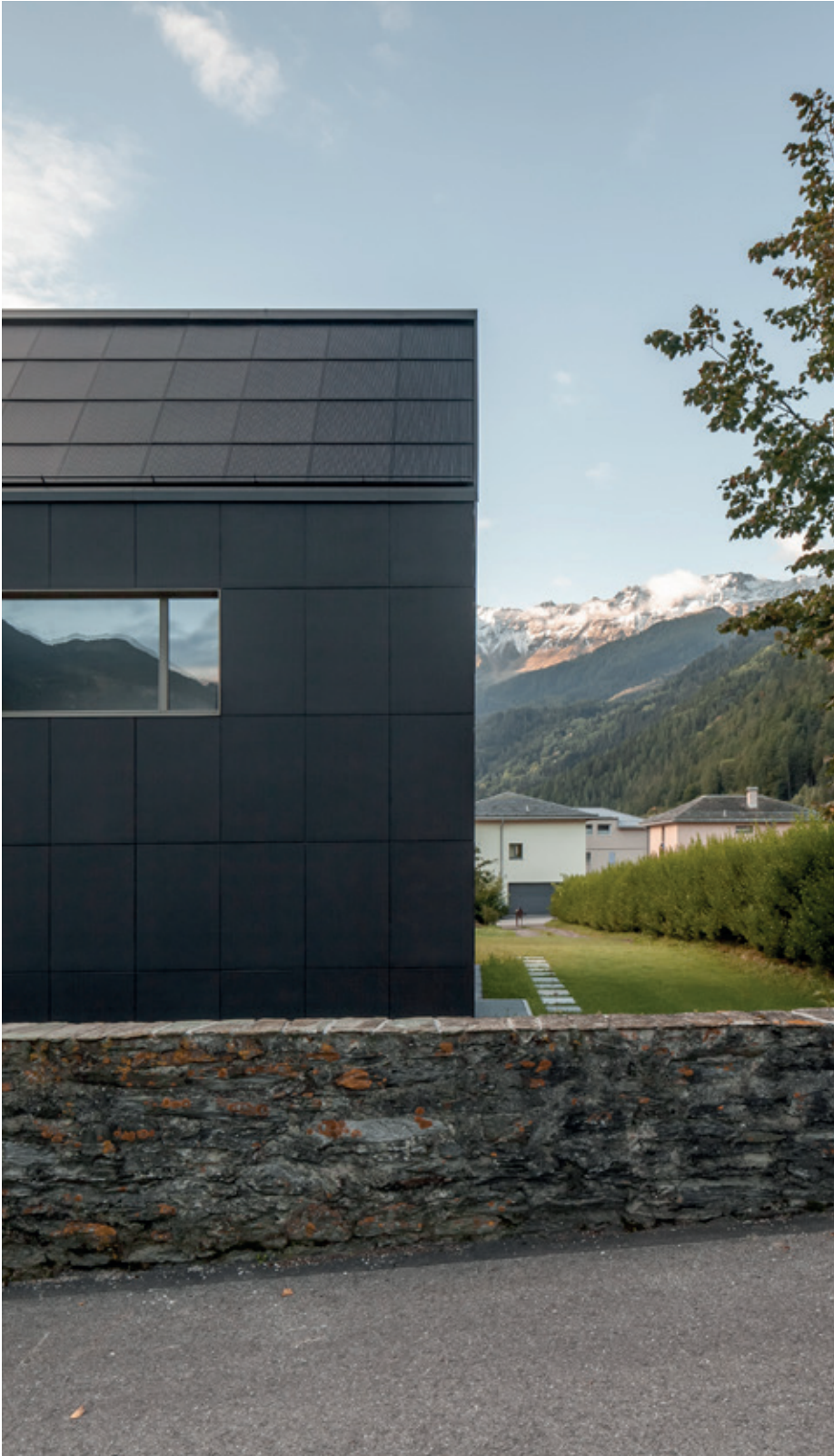
Für die Stromproduktion muss die PV-Anlage auf der Nordseite optimal ausgerichtet sein.
