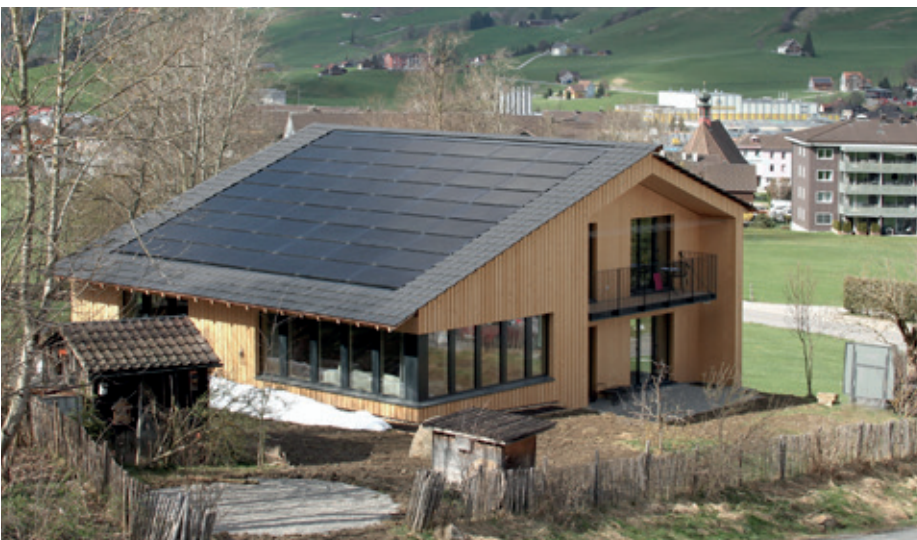
HEV-Sondersolarpreis: Die 17.8 kWp starke PV-Anlage produziert rund 16'600 kWh/a.
