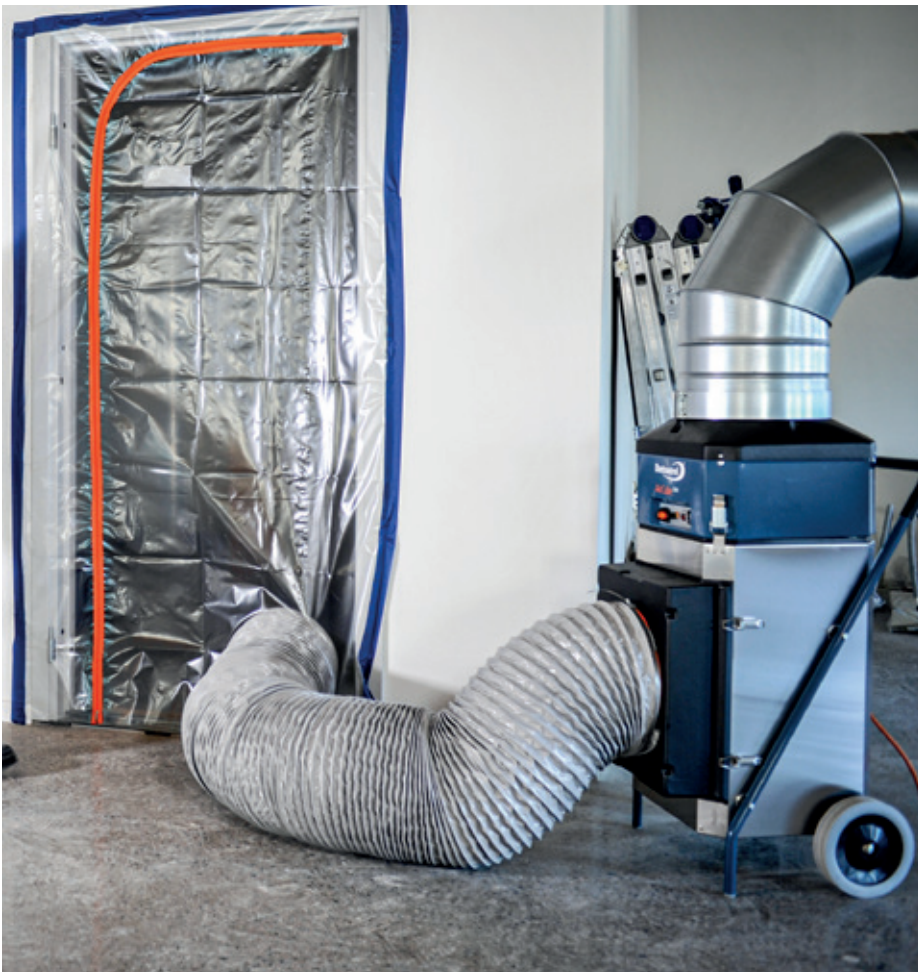
Staubschutzwand mit Klapptüre und Zugang für Luftreiniger.
