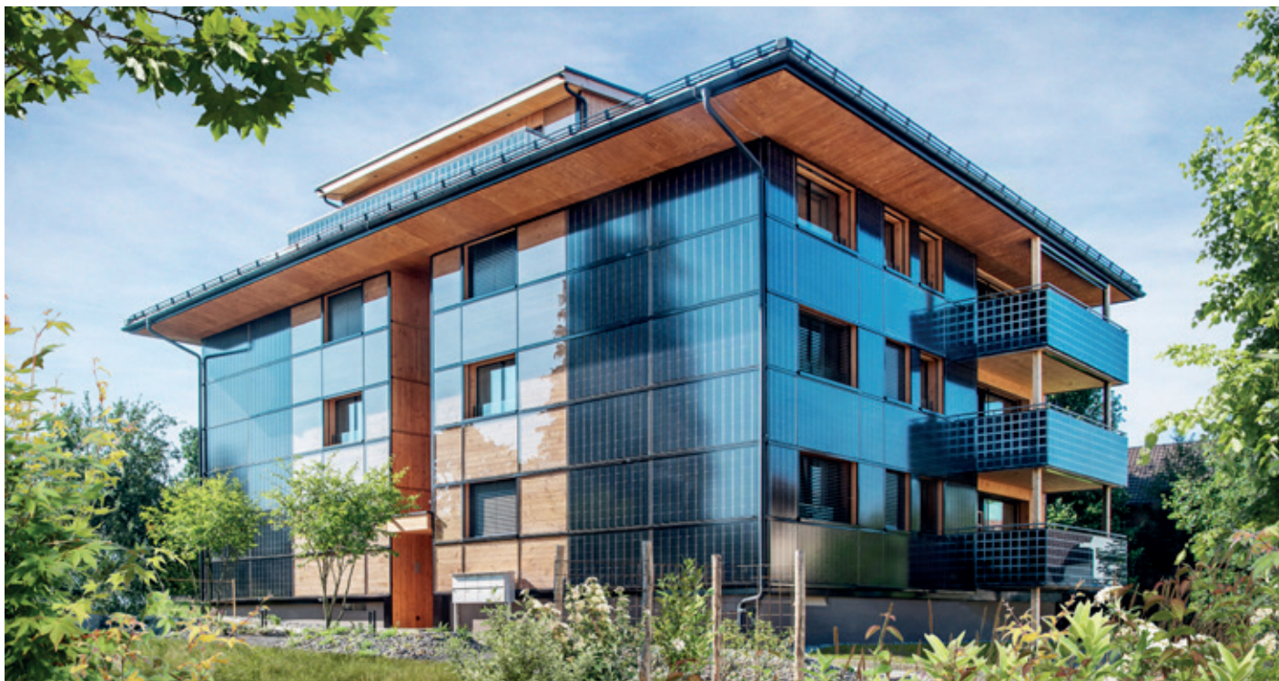
Das sanierte MFH in Fahrwangen (AG) benötigt noch 24'700 kWh/a. Der Gesamtenergiebedarf sank um 82 Prozent.
