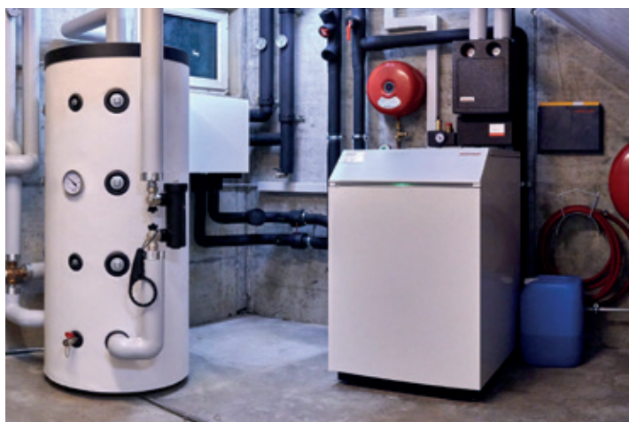
Die Sole-Wasser-Wärmepumpe von Weishaupt in Verbindung mit einem Wärmespeicher.
