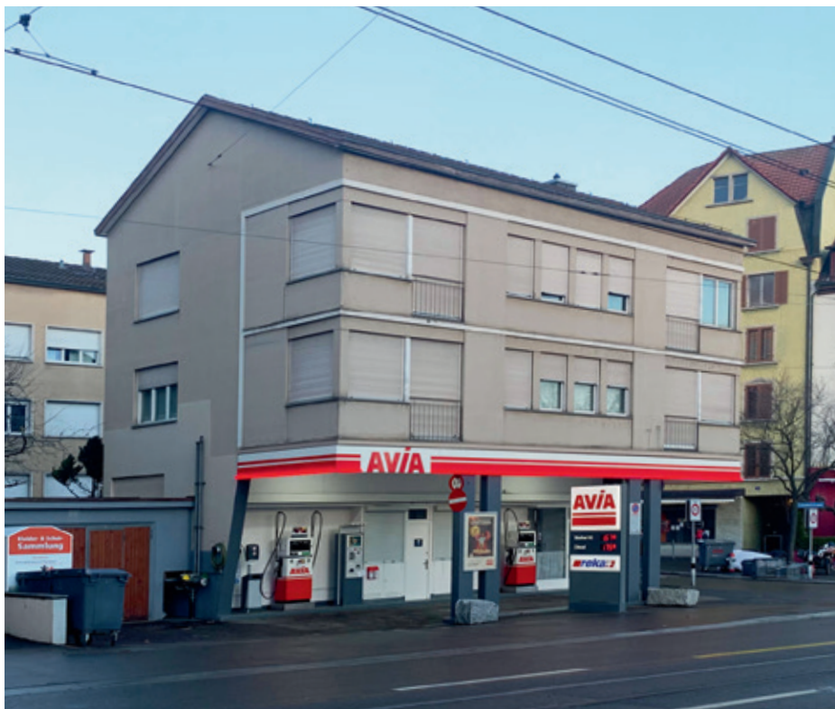
So sah das Haus mit Tankstelle in Zürich-Wollishofen vor der Sanierung und Aufstockung aus.
