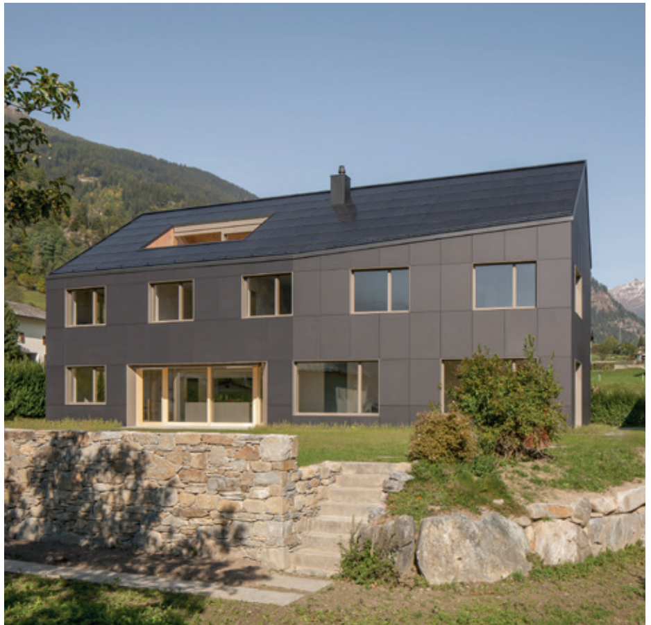
Fassade und Dach des Mehrfamilienhauses sind vollständig mit einer PV-Anlage ausgestattet.
