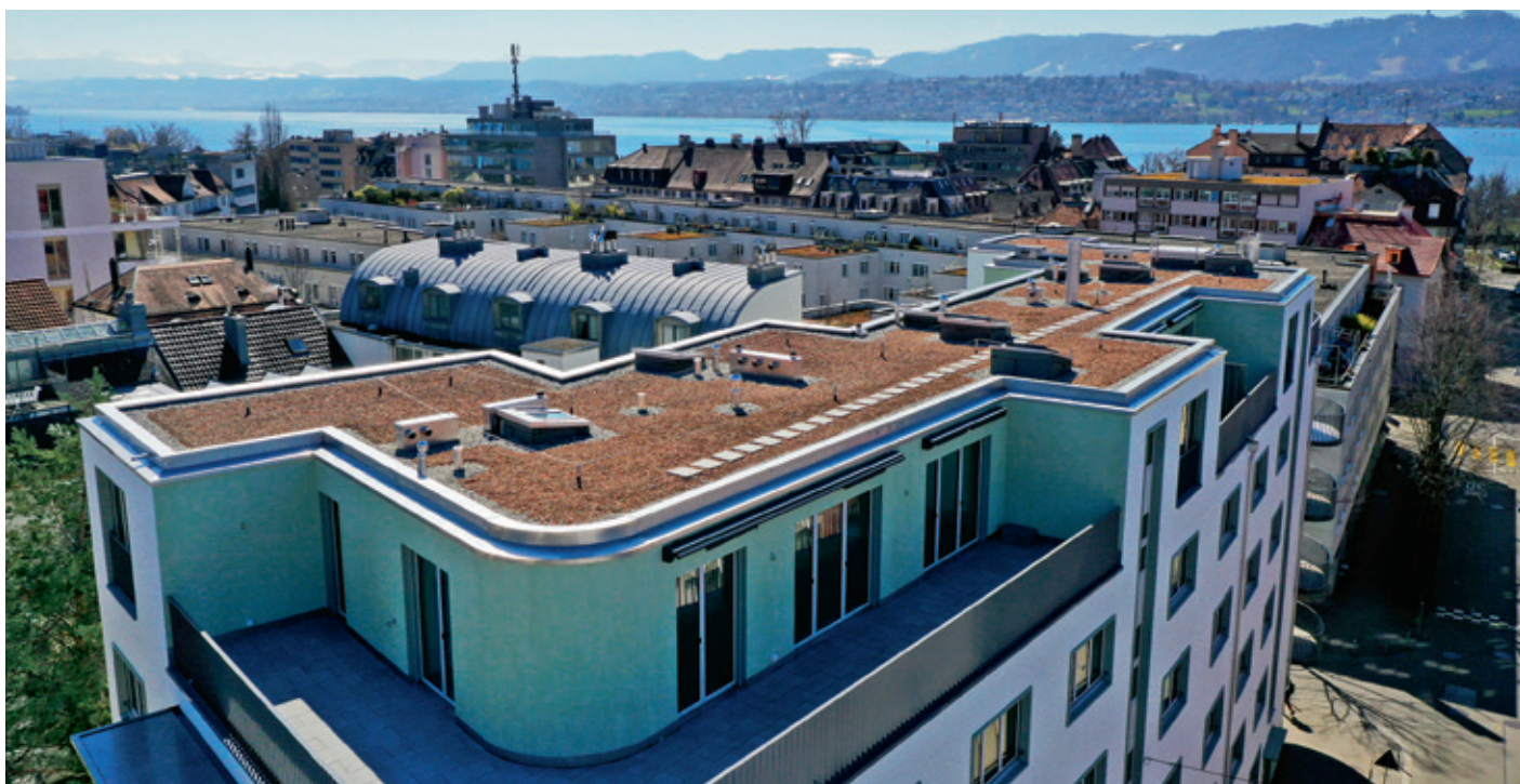
So zeigt sich die fertiggestellte Aufstockung im Zürcher Seefeld.
