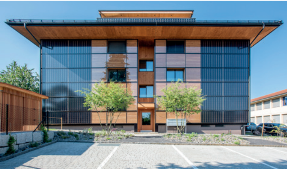
Die Holzstrukturen der solaraktiven Fassadenelemente schaffen einen Kontrast zu den Solarmodulen.
